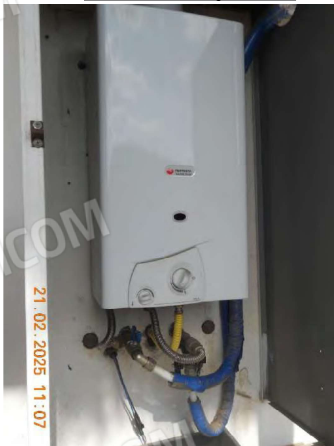
Foto n. 26 – Particolare caldaia a gas in disuso
