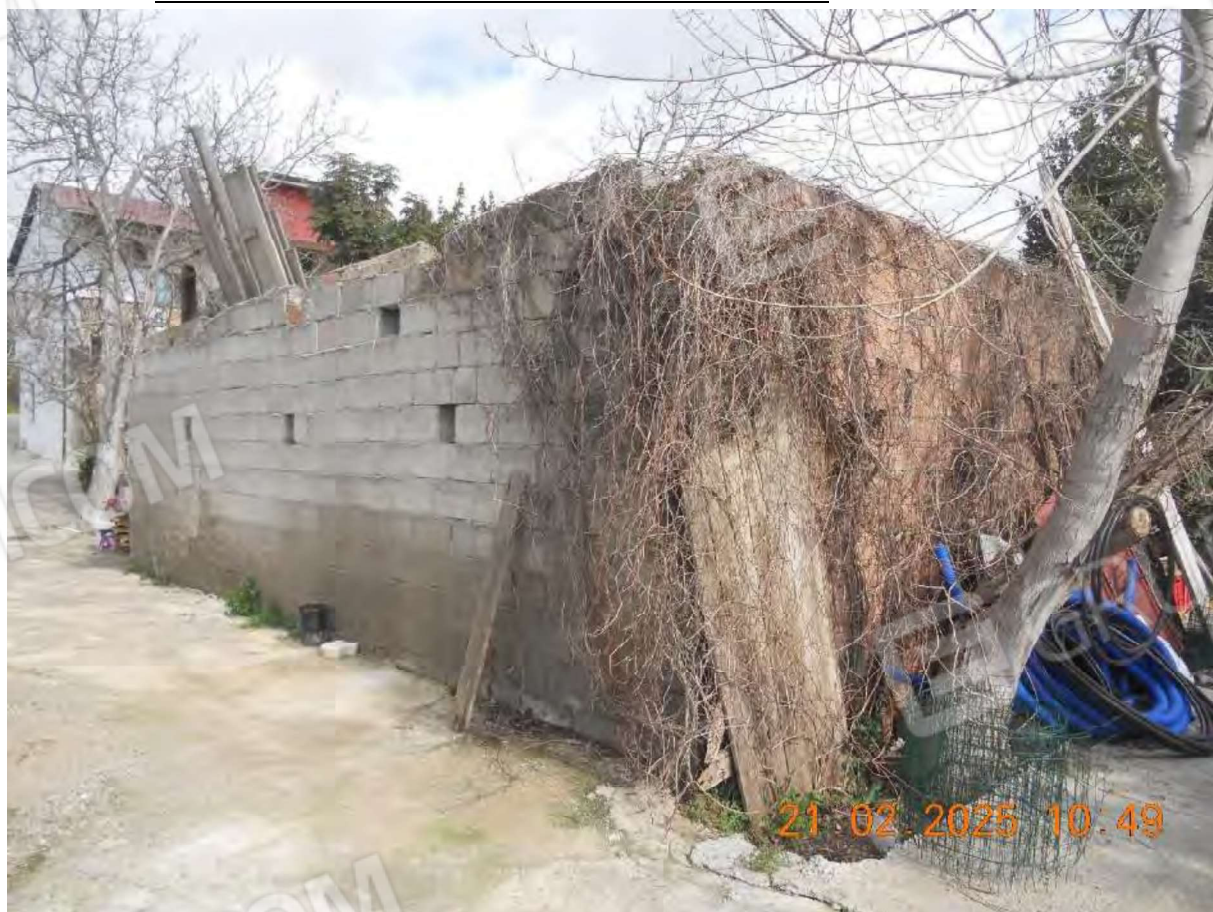
Foto n. 4 – Manufatto in blocchi di calcestruzzo e mattoni forati
